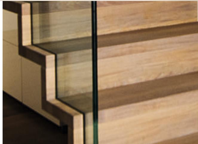
Seite 4: Treppe aus Eichenholz, grau geölt, mit der Wand verschraubt. Geländer aus Verbundsicherheitsglas, unten eingenetet und oben mit CNS-Handlauf.
