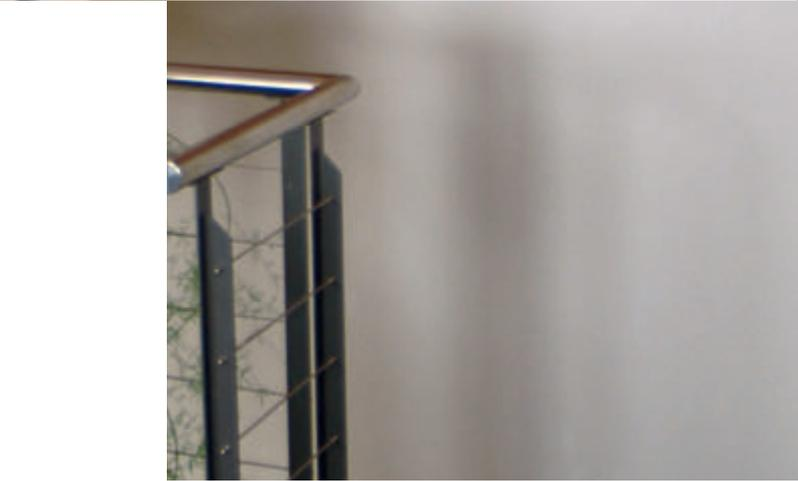
Seite 2: Treppe aus längsgezinktem Buchenholz, mit der Wand verschraubt. Geländer mit T-Pfosten, CNS-Handlauf und INOX-Seilen.
