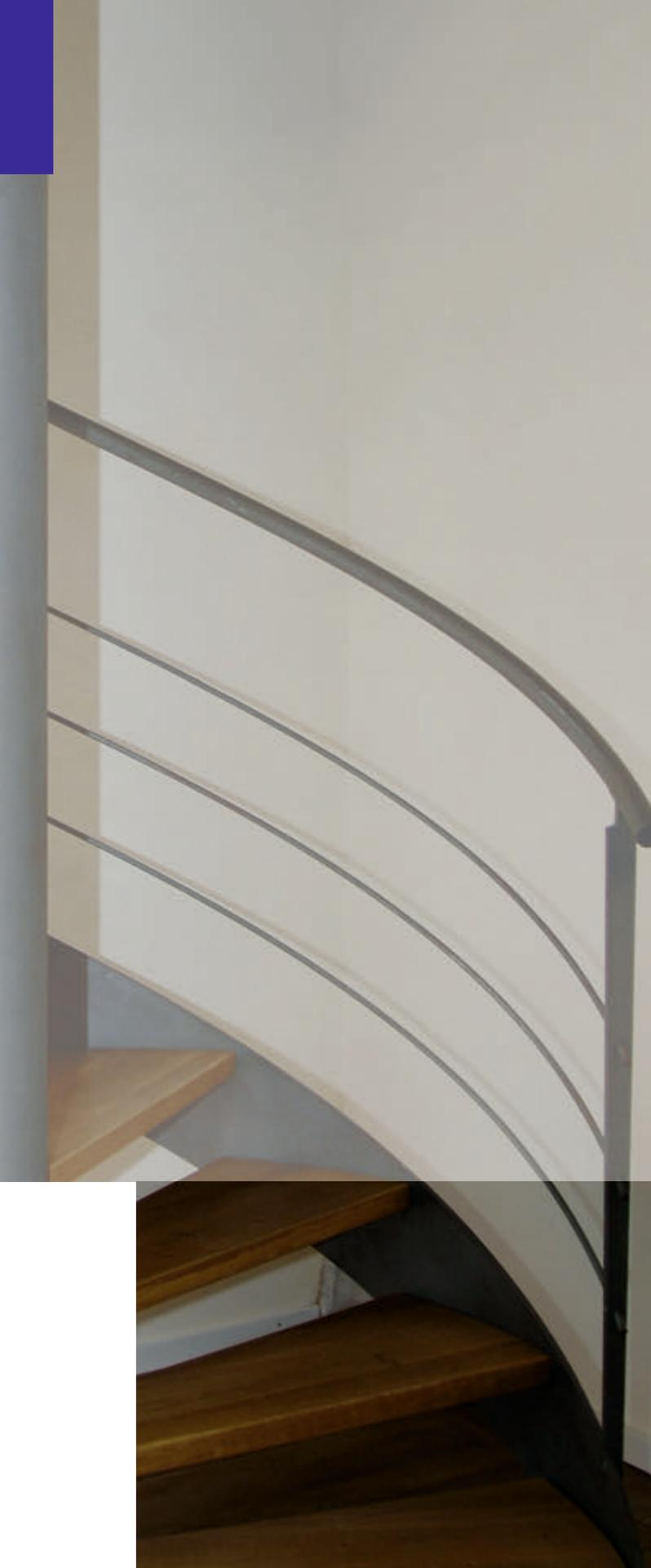
Stufen in Eiche, farblos lackiert. Säule, Aussenwange und Relinggeländer aus Metall mit behandelter Oberfläche.
