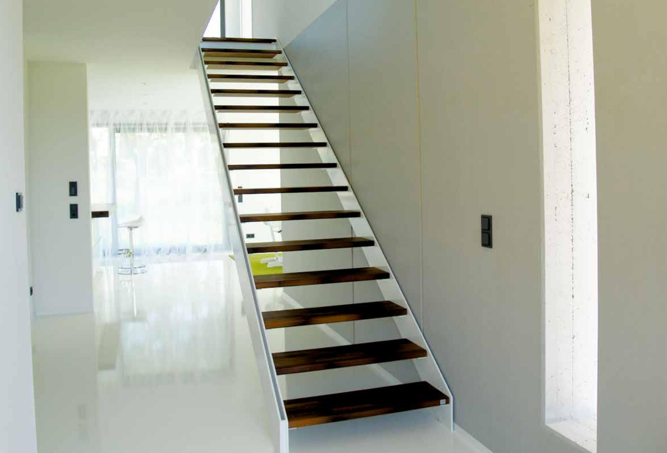
Die hohe statische Festigkeit der Werkstoffe ermöglicht eine besonders filigrane Ausführung der tragenden Wangen. Alle Stahlteile werden mit einer pulverbeschichteten Oberfläche ausgeführt. Diese Oberfläche ist besonders hochwertig und widerstandsfähig. Sämtliche Glimmertöne sowie RAL-Töne sind möglich. Auf Wunsch können auch Sonderfarbtöne realisiert werden. Wir verwenden ausschließlich
